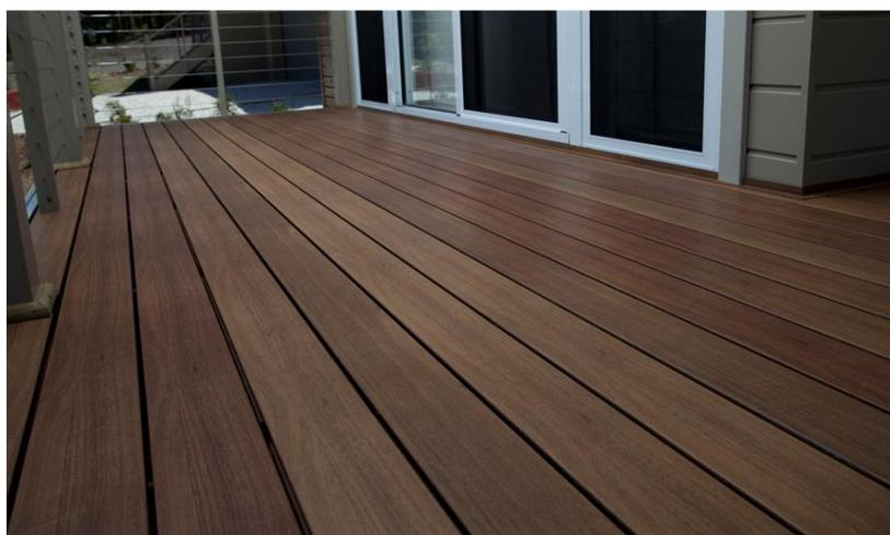
Figura 1: Pavimentazione antiscivolo con polveri *No-skid*, decorate con tecnologia di sublimazione.
